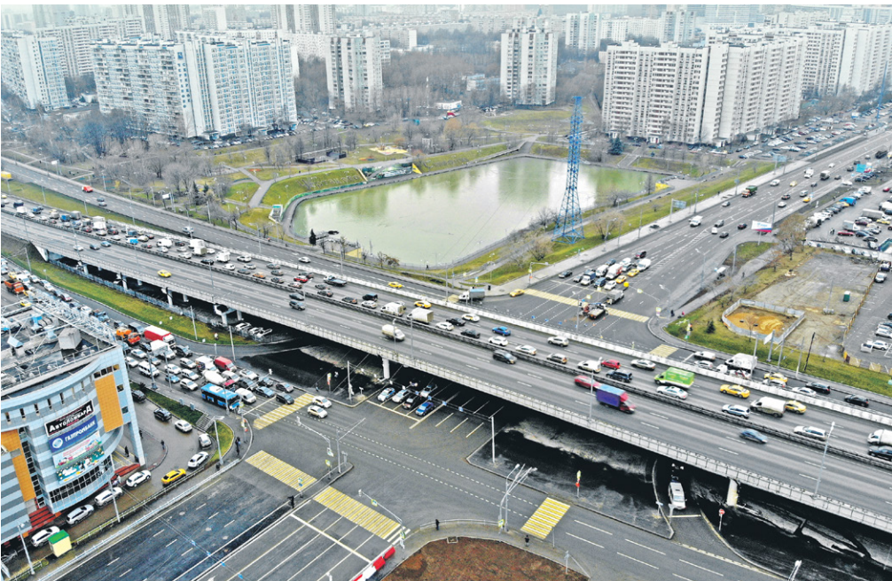
Достроен участок Южной рокады от Варшавского шоссе до Пролетарского проспекта
