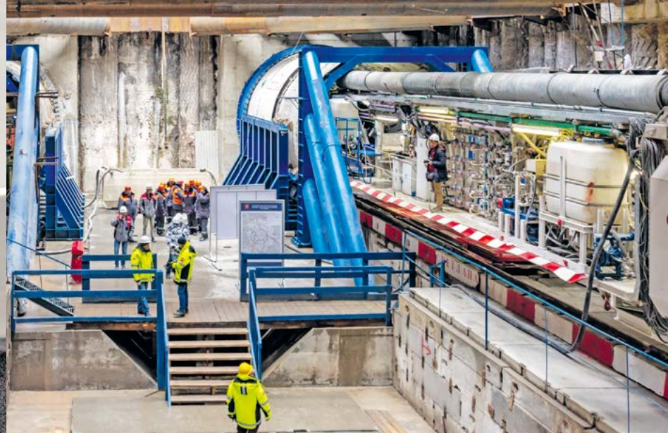
Старт проходки ТПК «Светлана» от станции «Нижние Мневники» к станции «Улица Народного Ополчения». Комплекс пройдет под землей более 1,8 км. Трасса протянется под каналом им. Москвы вблизи шлюза № 9 Карамышевского гидроузла. Расстояние от свода тоннеля до дна канала составит около 13 метров
