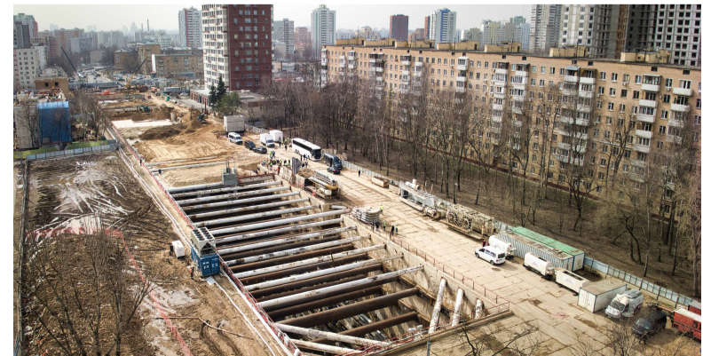
Строительство станции «Народное Ополчение» Рублёво-Архангельской линии метро
