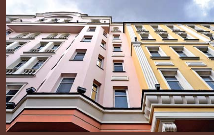
Комплекс административных зданий в Большом Кисловском пер.
