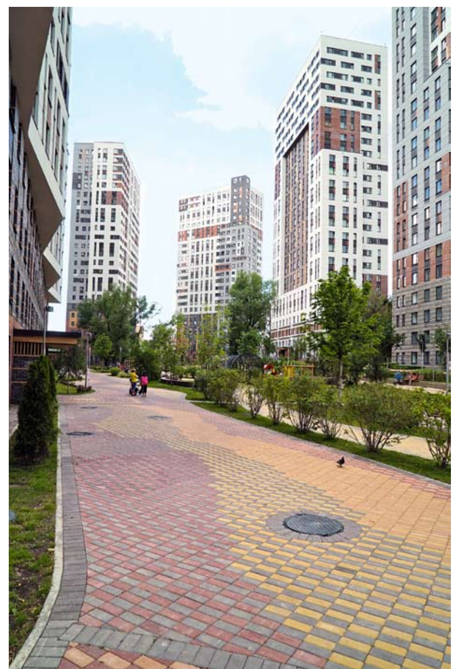
Жилой дом возводится по принципу вертикального города: на нижних этажах расположится многоуровневый паркинг, а над ним – квартиры
