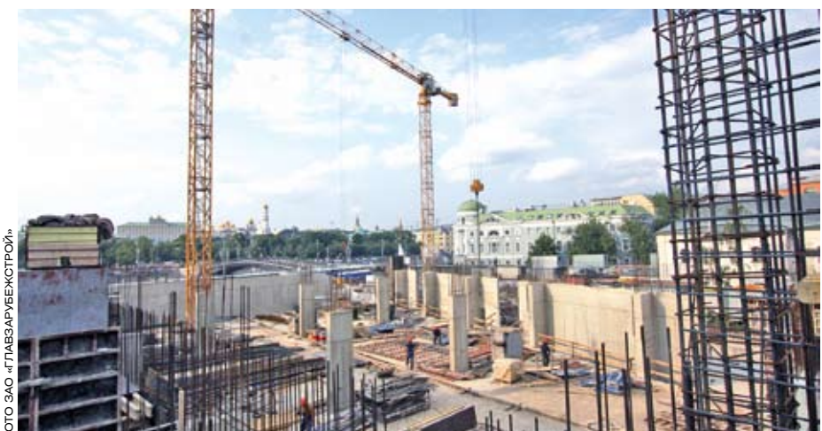
На сегодняшний день завершаются работы в подземной части здания, а со стороны, противоположной Кадашевской набережной, работы ведутся на уровне второго этажа
