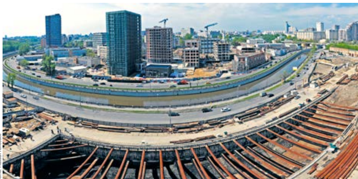
Фото: Михаил Колобнев Строительство станции метро «Рубцовская»
