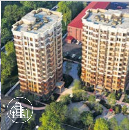
ЖК «Дом на Рогожском Валу»
