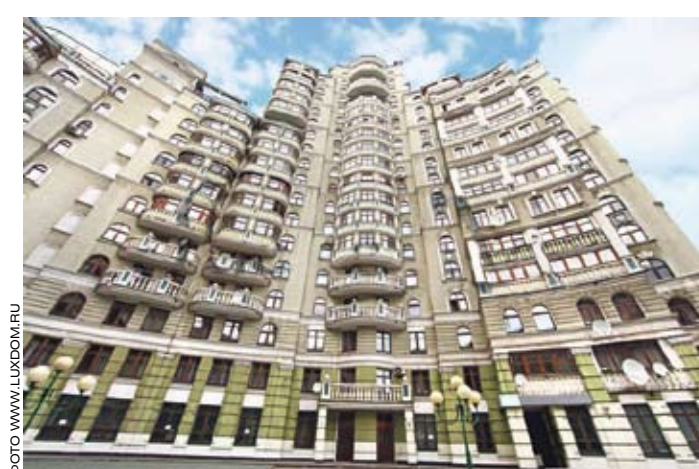
Жилой комплекс на ул. Краснопротарской, 7
